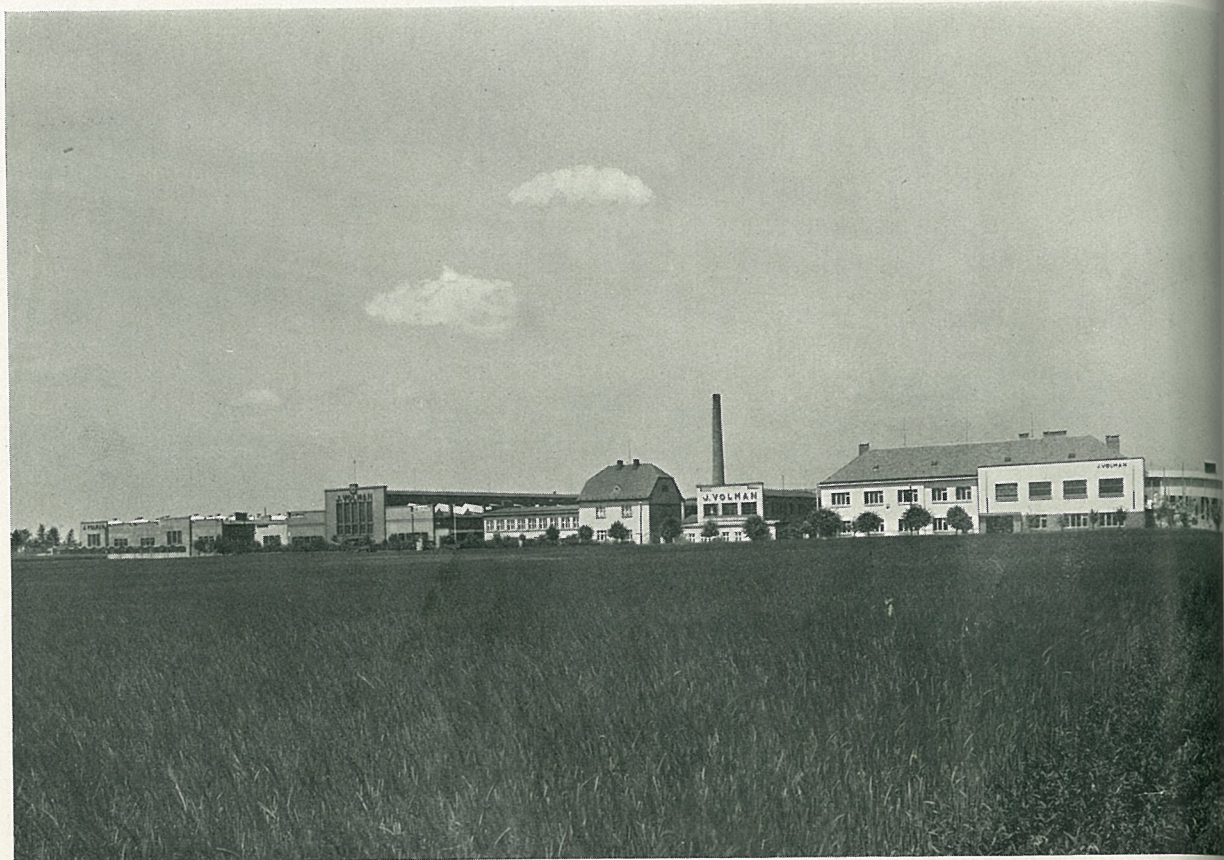
CELKOVÝ POHLED NA ZÁVOD V ČELÁKOVICÍCH V ROCE 1940
