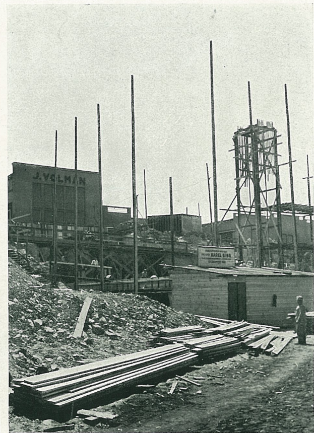
STAVBA NA ZADNÍM TRAKTU
