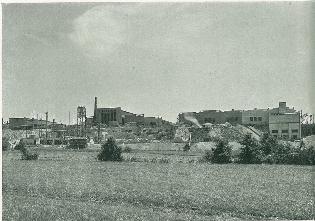
STAVBA NA ZADNÍM TRAKTU TOVÁRNY
