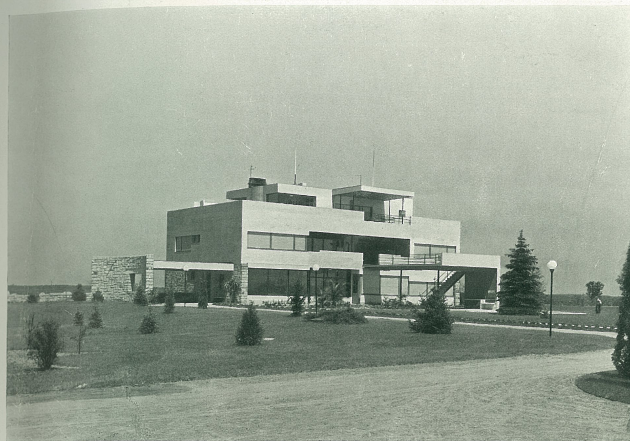
BUDOVA VEDENÍ PODNIKU
