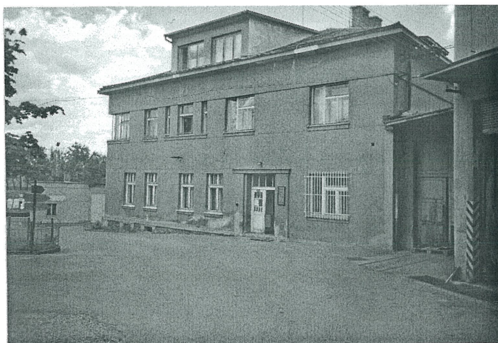
Administrativní budova jaro 2004
