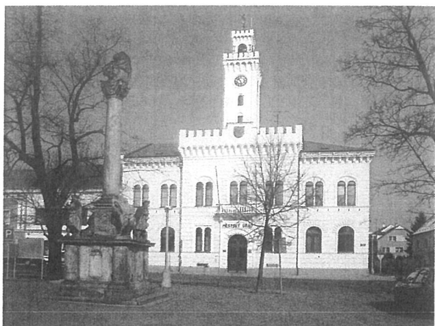
Postoloprtská radnice s renovovanou fasádou (archiv Nadační spolek Žatec)
